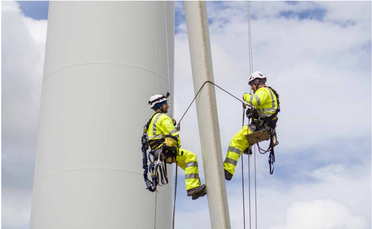
Service-Arbeiten an Windkraftanlage
