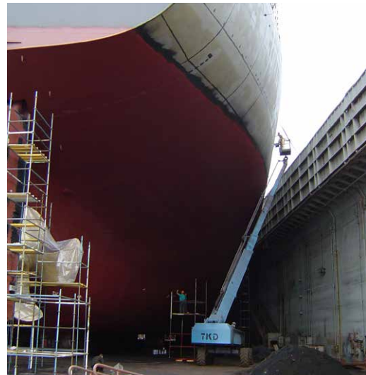
Korrosionsschutz-Arbeiten an Schiffsrumpf
